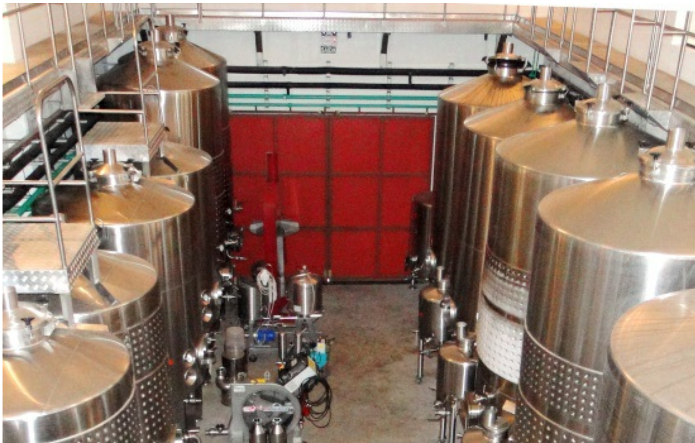
3. As uvas, tintas ou brancas, são fermentadas em tanques de aço, com controle de temperatura
