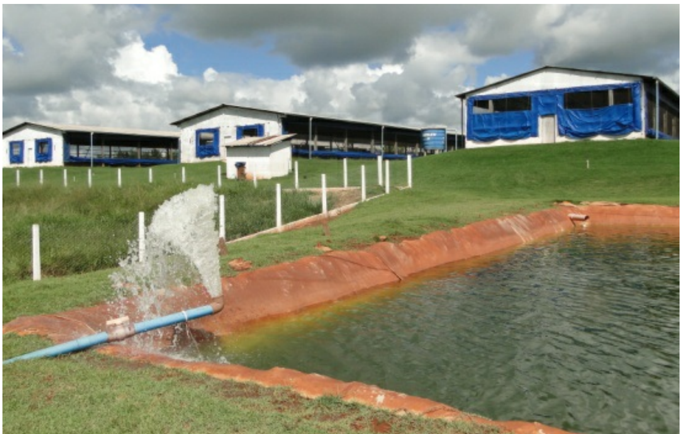
3. A água de chuva desce por gravidade dos telhados dos barracões e é oxigenada em um pequeno chafariz, antes de encher a cacimba
