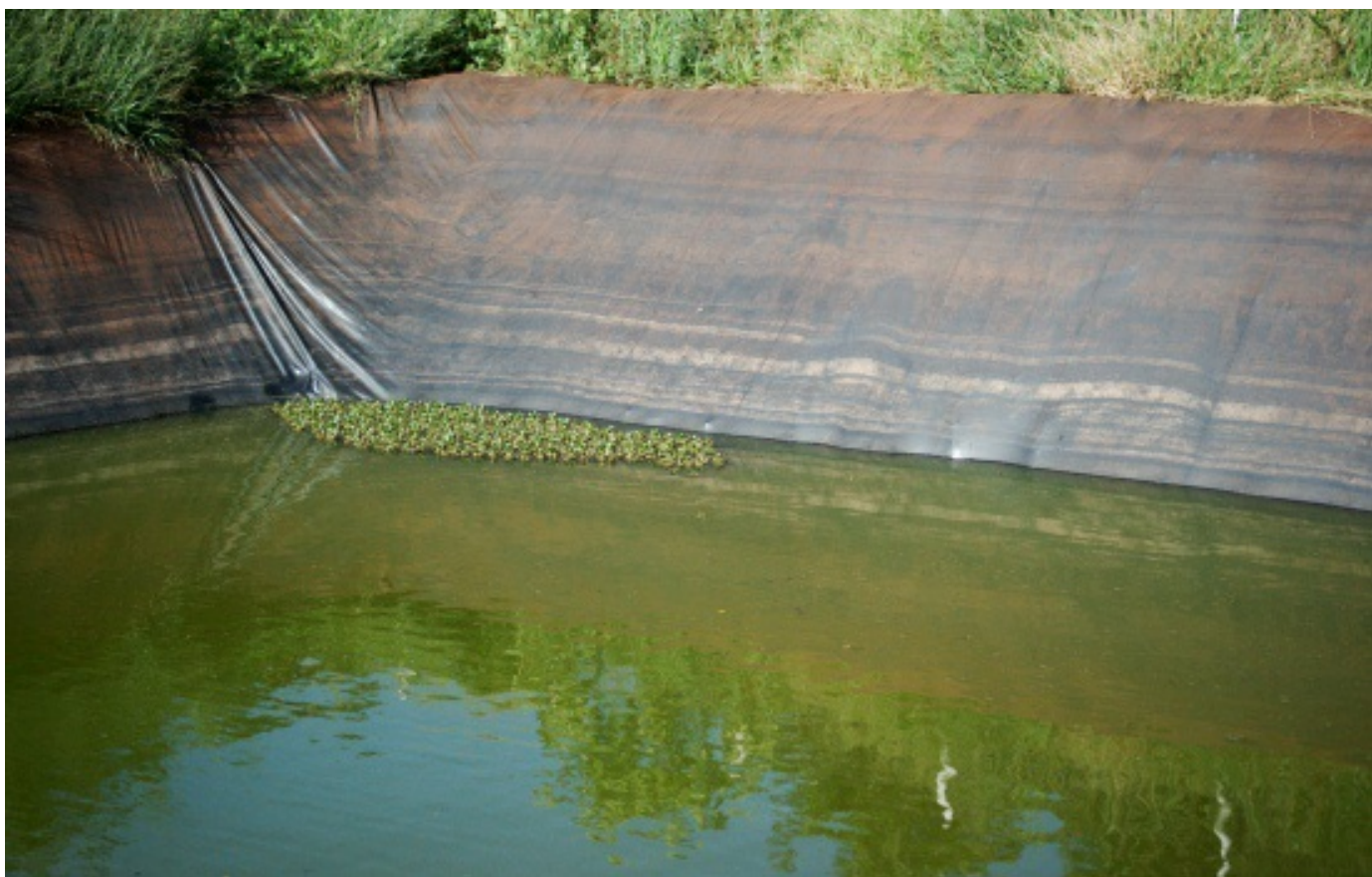
4. As cacimbas são buracos na terra revestidos com uma lona plástica bem resistente
