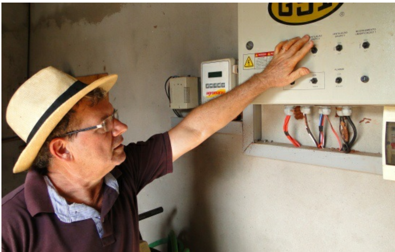
12. Em um único painel, Afonso Rosalen monitora a temperatura e a umidade do ar nos recintos e checa o funcionamento de boias, ventiladores, aspersores e bombas
