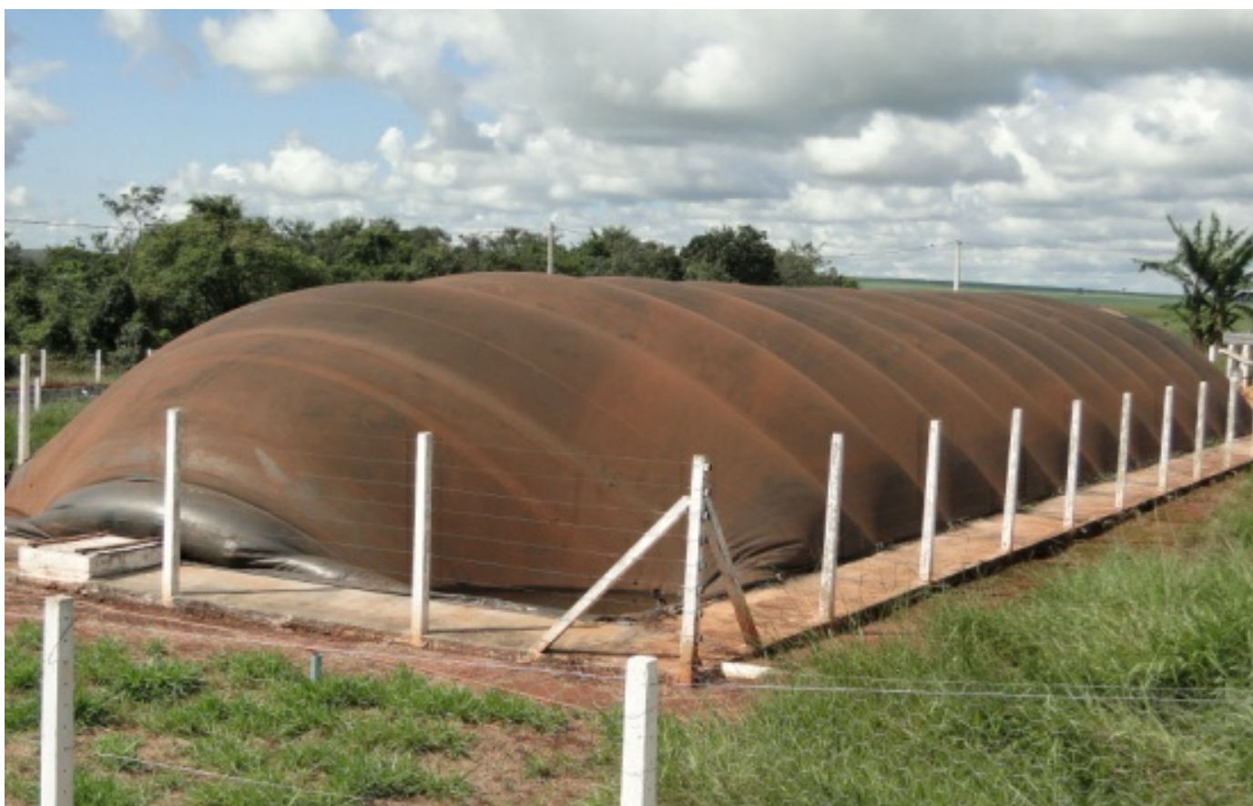
9. O biodigestor transforma os dejetos em dois produtos utilizados na própria granja: biogás e biofertilizante líquido
