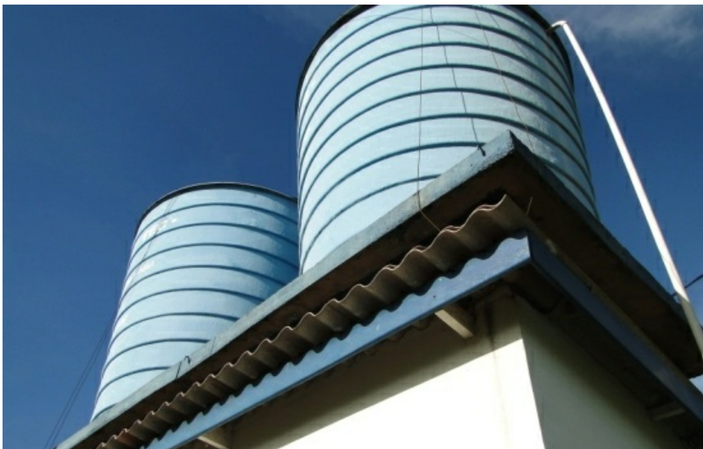
6. Apenas a água de beber é bombeada dos poços artesianos e fica estocada nestas duas caixas
