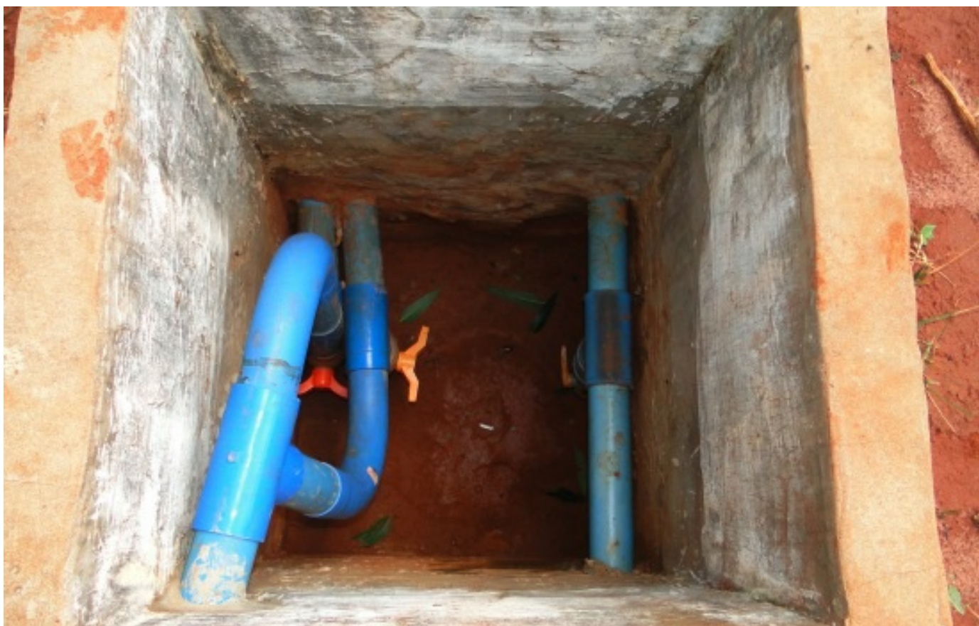
6. O biogás chega aos geradores por um encanamento subterrâneo e é filtrado antes de seguir para os geradores.
