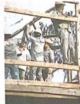
Demolição da lanchonete
